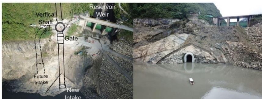
Gambar 16. Intake Baru Waduk La Esmeralda
