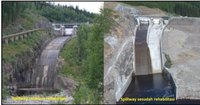
Gambar 10. Modifikasi pelimpah di Bendungan Holjes
