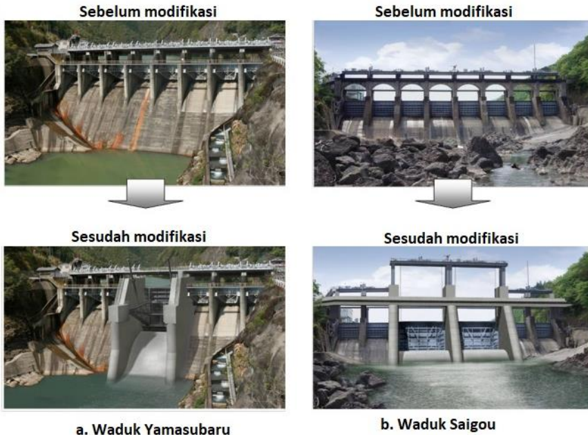
Gambar 12. Modifikasi pelimpah Waduk Yamasubaru dan Waduk Saigou
